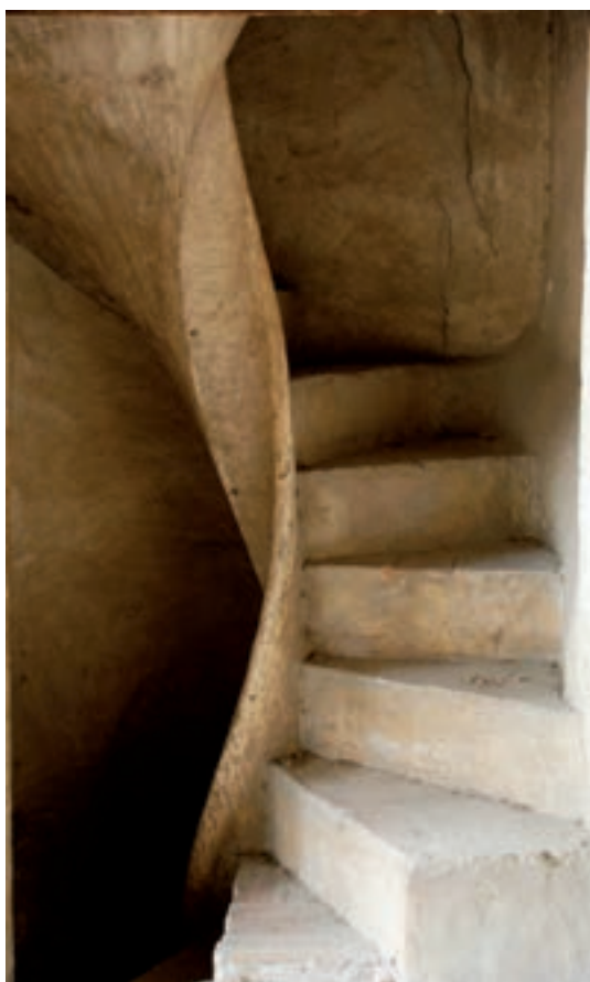
Fig. 8.- Escaleras de acceso a las cubiertas del antiguo monasterio de Santa Clara (Játiva) edificadas en el siglo XVIII. La imagen de la derecha muestra el aparejo tabicado por hiladas transversales de su helicoide.
